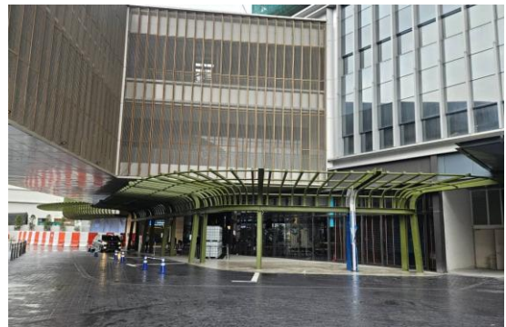
รูปที่ 23 ตัวอย่างโครงสร้างเหล็กของอาคาร-ส่งแท็กซี่
