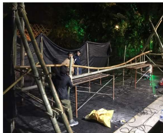
รูปที่ 11 จัดวางในพื้นที่เตรียมประกอบในด้านล่างก่อนเพื่อความสะดวกในการติดตั้ง
