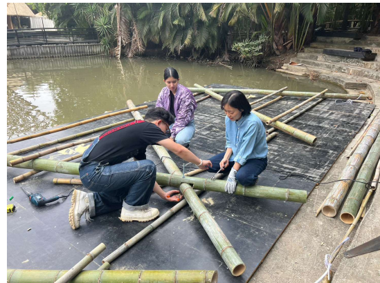
รูปที่ 8 การสร้างฐานรูปกากบาทสำหรับรับน้ำหนักหลังคา
