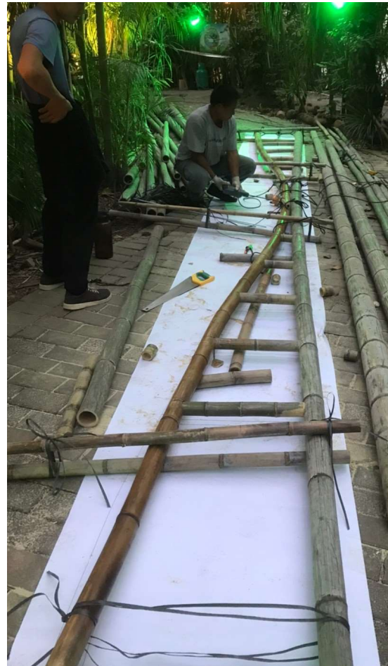
รูปที่ 10 ประกอบโครงสร้างคานหลังคาช่วงพาดกว้างและตัดโค้งด้วยการเผาไฟ
