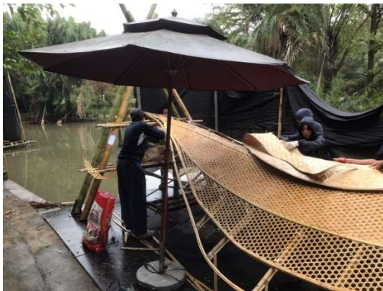
รูปที่ 13 ติดตั้งแผ่นวัสดุผุงหลังคา
