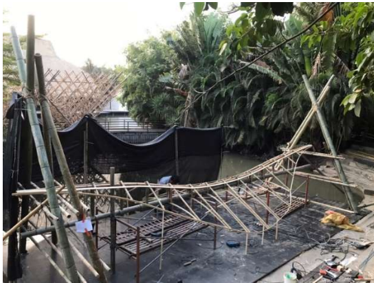
รูปที่ 12 ประกอบส่วนจันทันเข้ากับโครงถักช่วงพาดกว้าง
