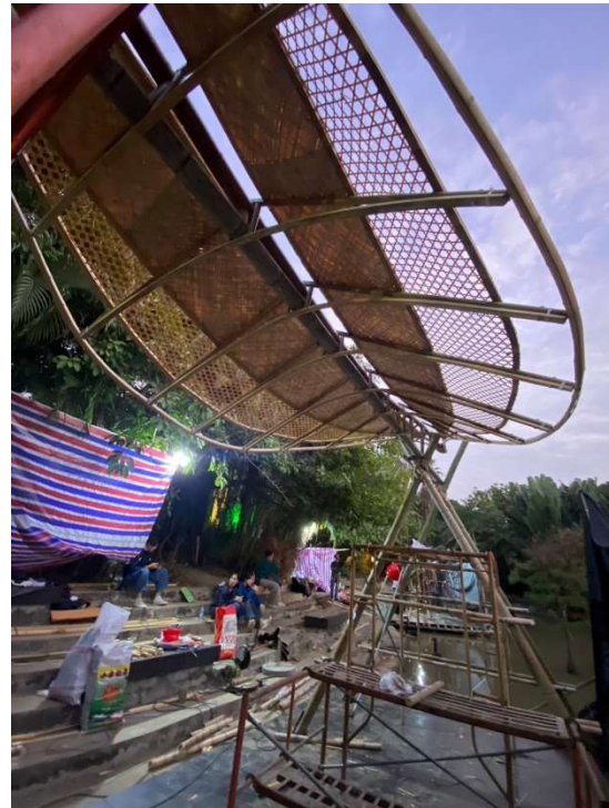
รูปที่ 14 ยกขึ้นติดตั้งบนโครงสร้างรับน้ำหนักที่จัดเตรียมไว้
