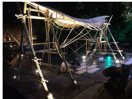
รูปที่ 18 ติดตั้งระบบแสงสว่าง
