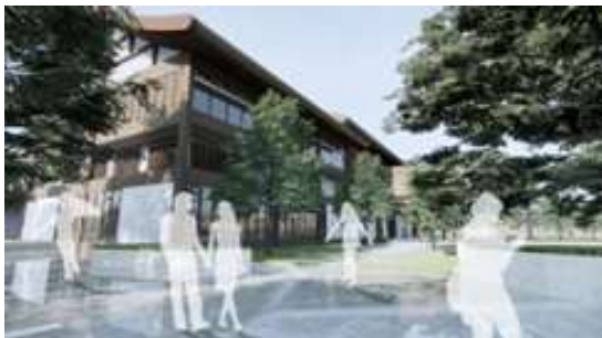
รูปที่ 24 ทศนิยมภาพภายนอกโครงการ (2)
