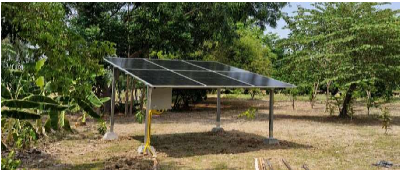
ภาพที่ 1 การติดตั้งระบบโซลาร์เซลล์ เพื่อใช้กระแสไฟฟ้าจากพลังแสงอาทิตย์
